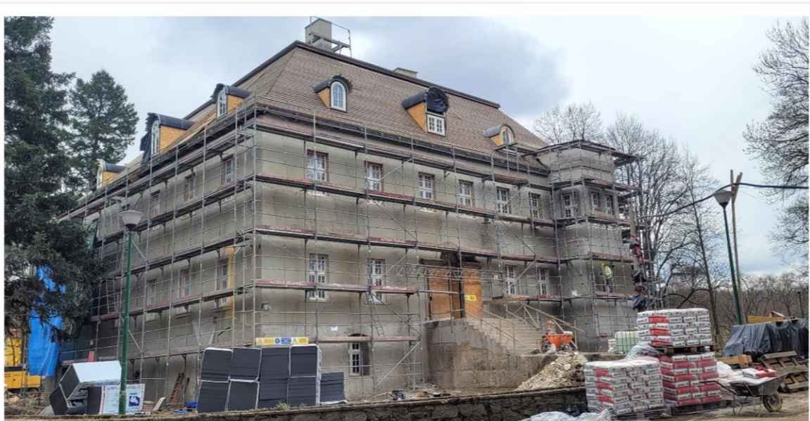
Fot. Pałac w Bukowcu w remoncie – marzec 2024 r.
